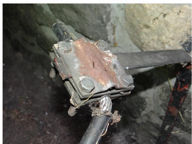
Sposób podpięcia instalacji w wiatraku z Grzawy ze zbiorów MGPE (fot. P. Roszak-Kwiatek)
