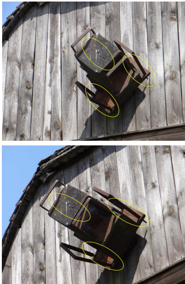
Widoczne pęknięcia głowicy wiatraka z Zalesia ze zbiorów MWM w Sierpcu (fot. P. Roszak-Kwiatk)
