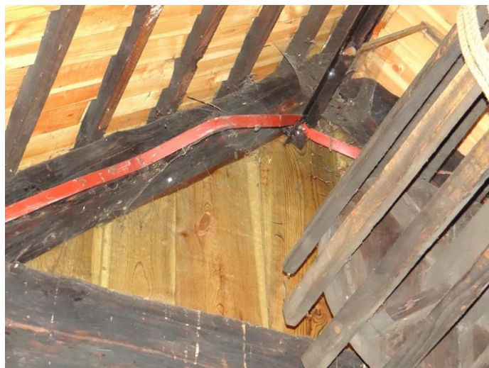
Połączenia masztów pod kalenicą wewnątrz wiatraka z Grzawy ze zbiorów MGPE (fot. P. Roszak-Kwiatek)
