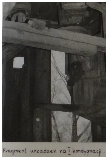
Dokumentacja archiwalna wiatraka z Zalesia (MWM w Sierpcu)
