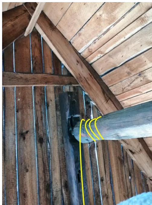
Zaznaczona na żółto lina znajdująca się na końcu wału windy – za jej pomocą wciągało się worki ze zbożem na wyższą kondygnację (fot. P. Roszak-Kwiatek)
