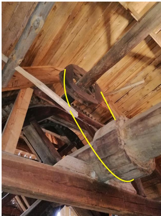
Połączenie windy z wałem skrzydłowym (fot. P. Roszak-Kwiatek). Na żółto dorysowana lina, której naprężenie zasprzęgłało windę.
