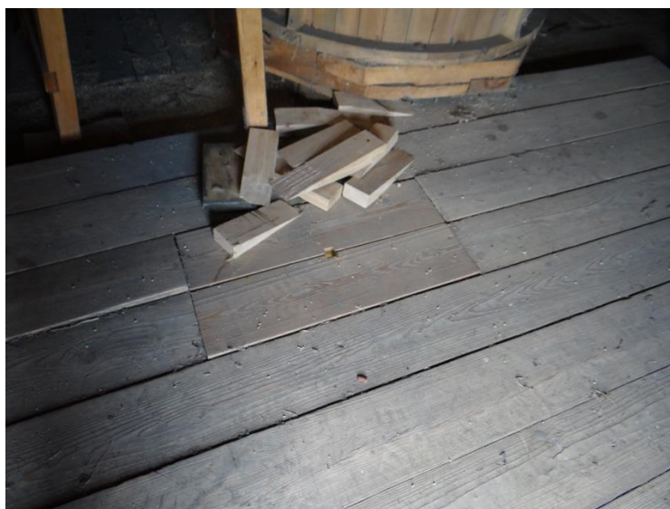
Zapadnia przez którą wciągało się worki z dolnej kondygnacji
