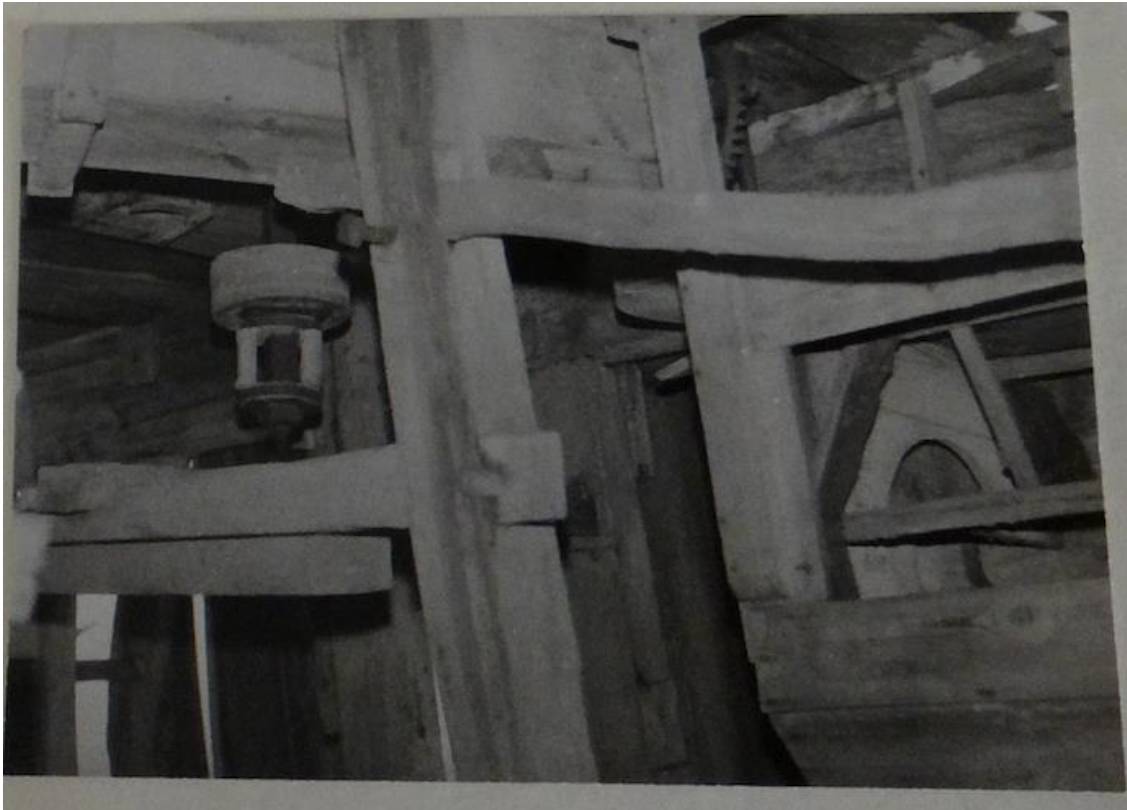
Historyczne i współczesne rozplanowanie regulacji kamieni w wiatraku z Zalesia w MWM w Sierpcu (fot. P. Roszak-Kwiatek)
